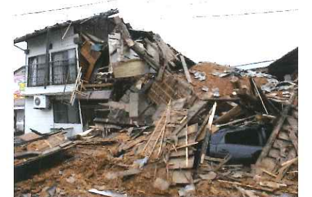
倒壊した家屋
